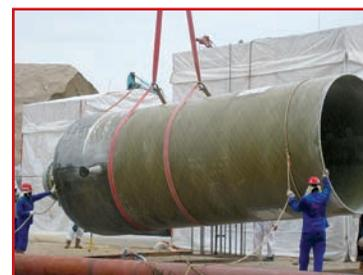
Tanques em filament winding: aplicação tradicional
