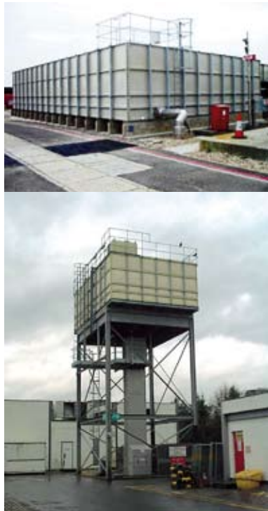
Figura 1 - Tanques de água com sistema modular
