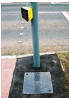
Figura 2 - Tampa retangular de poço de inspeção
