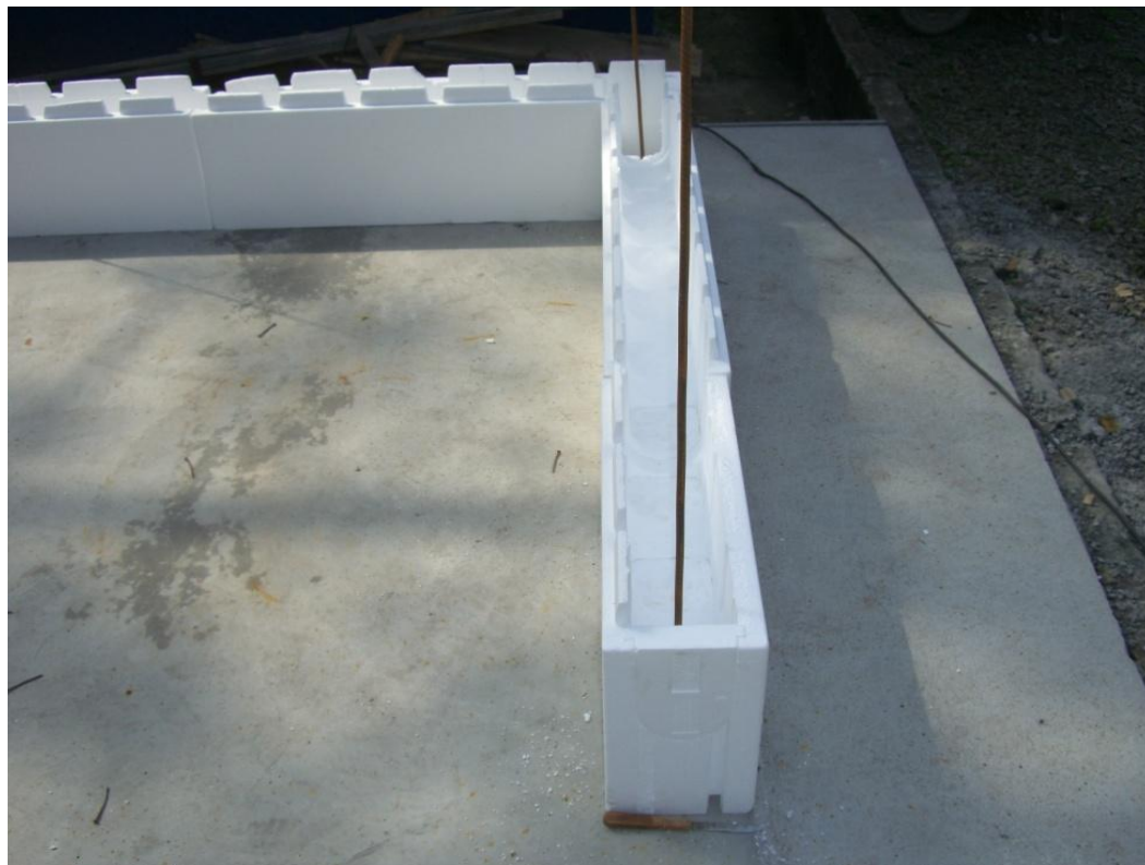
Posicionamento viga de fundação e pilares
