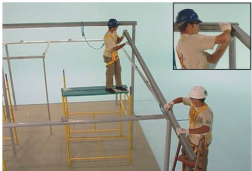
Montagem da estrutura metálica
