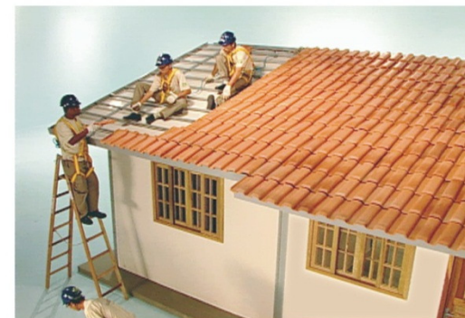
Fixação das telhas e acabamentos
