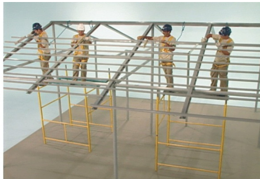
Montagem da estrutura do telhado
