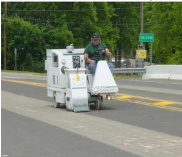
Aplicação do Sistema de Resina
