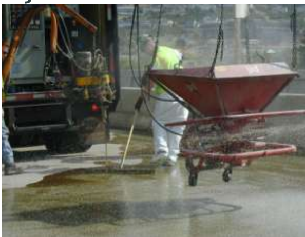
Aplicação do Sistema de Resina
