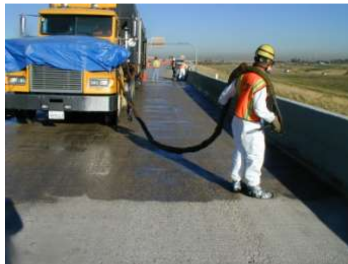
Aplicação do Agregado
