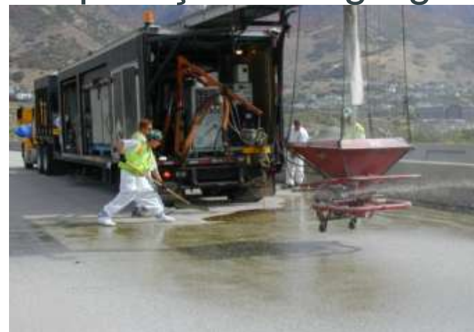
Aplicação do Agregado
