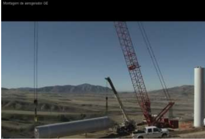
Montagem de aerogerador GE
