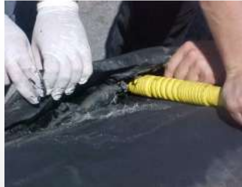
ESTADO DO MANGOTE E PREPARAÇÃO DE SUPERFÍCIE
