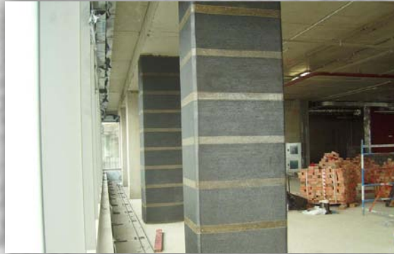
Recuperação de colunas com fibra de carbono
