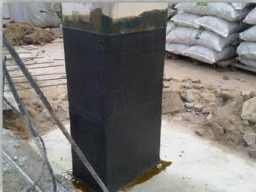
Recuperação de colunas com fibra de carbono
