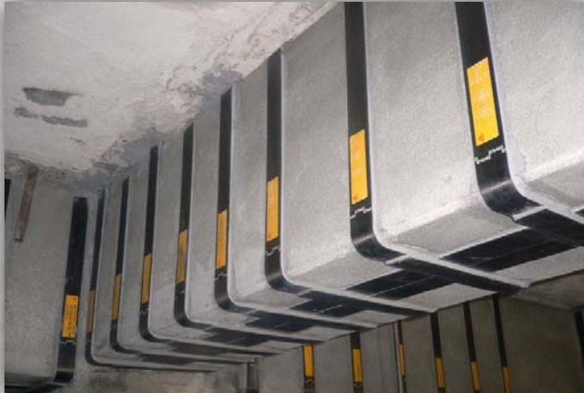
Reforço de vigas com fibra de carbono
