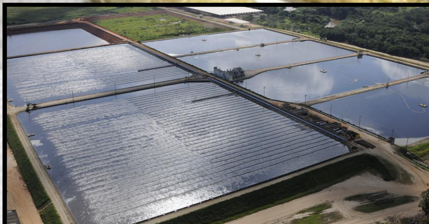
Estações de tratamento de afluentes
