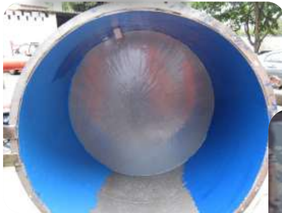
APLICAÇÃO DA CAMADA
