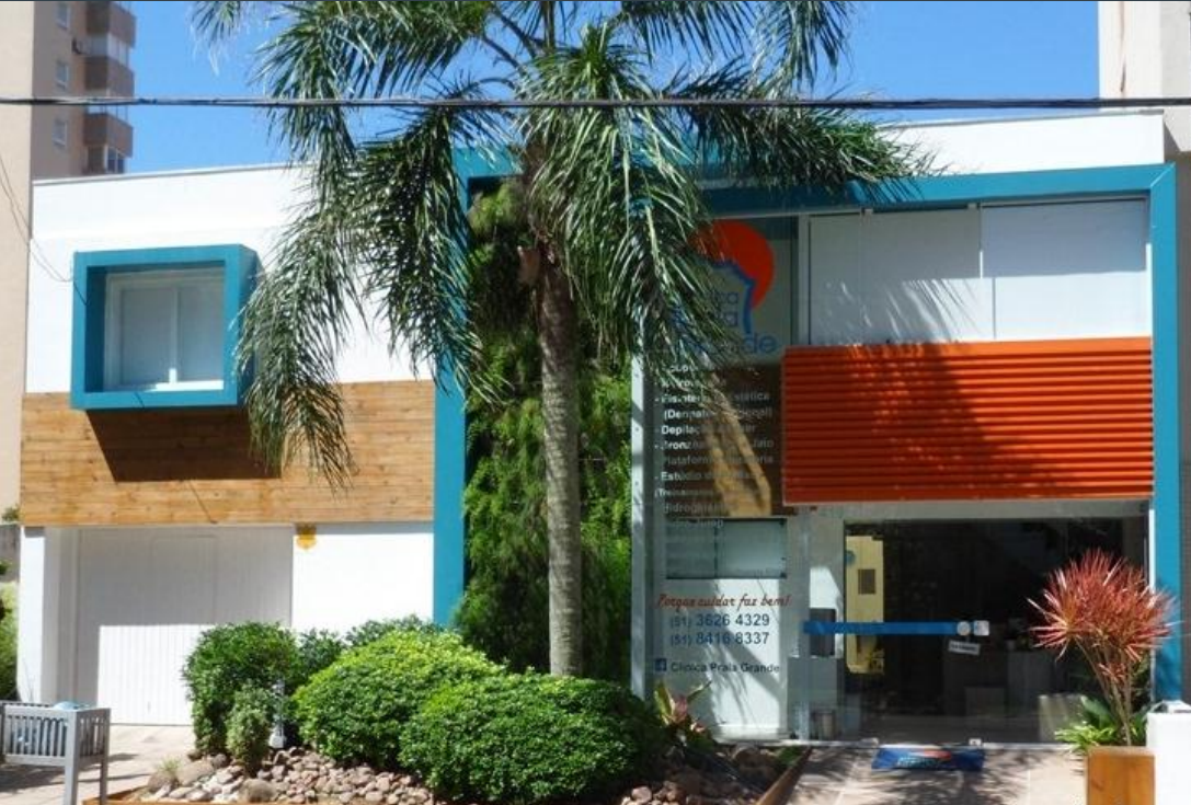
Fachada renovada com perfis pultrudados
