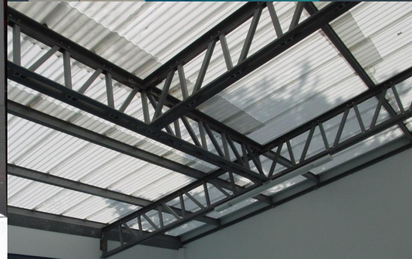
Escada para piscina e estrutura do telhado
