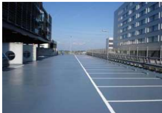
Impermeabilização + acabamento final
