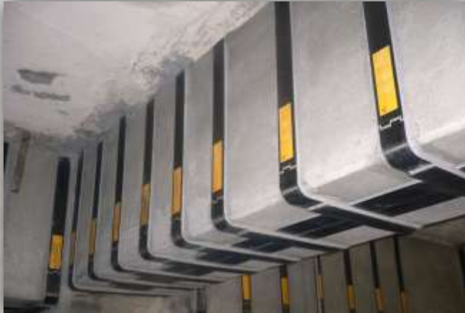
Reforço de vigas com fibra de carbono
