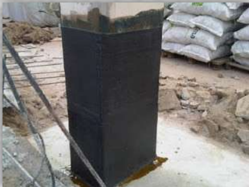
Recuperação de colunas com fibra de carbono
