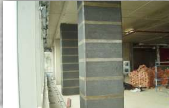
Recuperação de colunas com fibra de carbono
