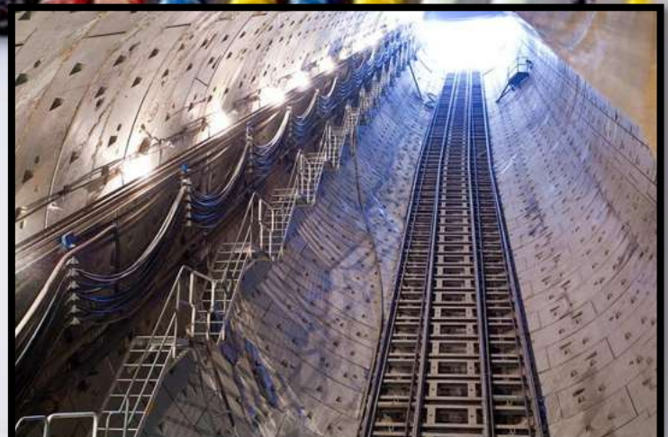
Construção de Túneis
